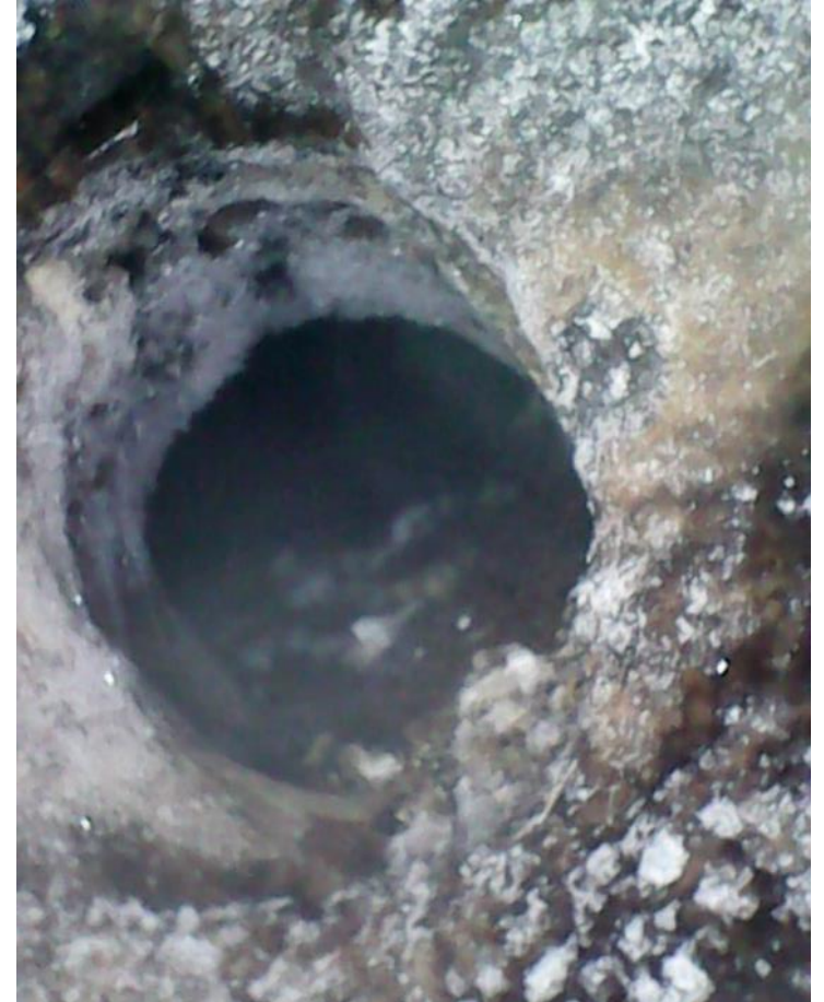
Piuhakameralla kuvattu kolo, joka on selvästi onkalomainen.
