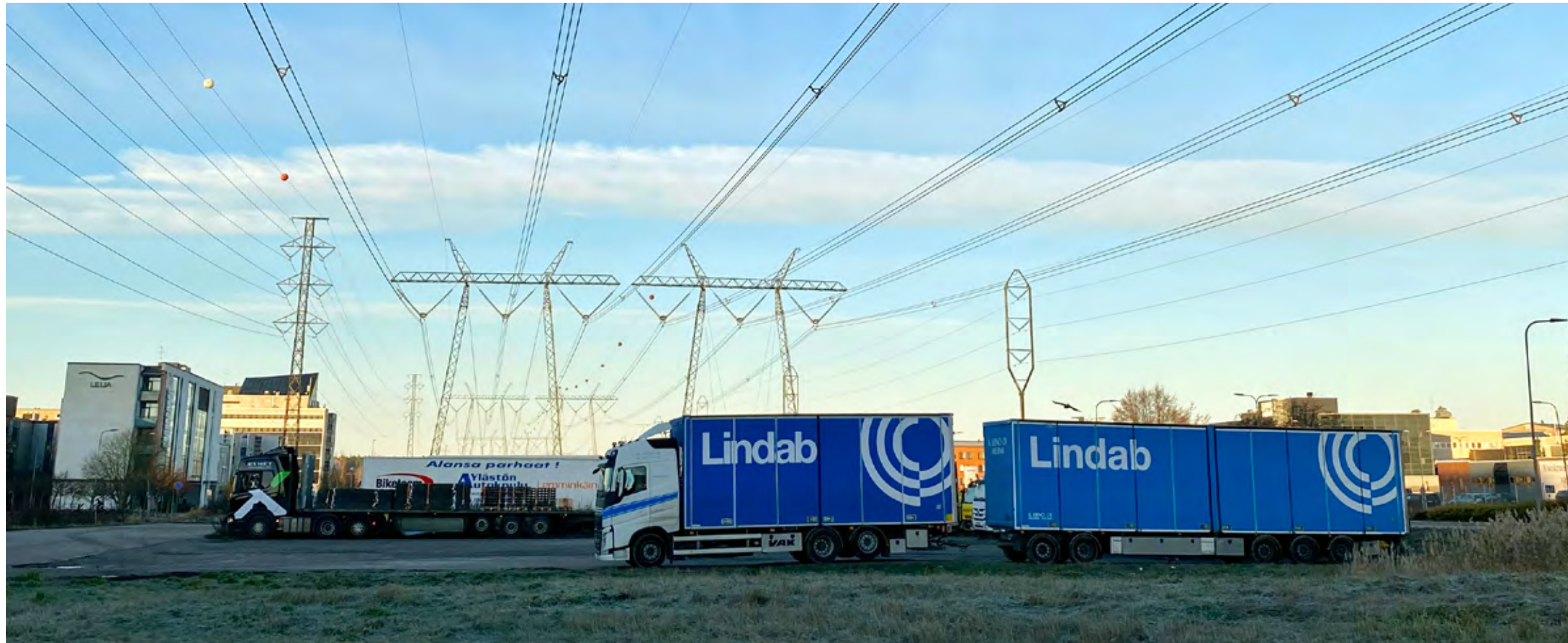
Kuva 4.21 Voimajohdot 400kV Pakkalassa. [Kuva: Tiina Hulkko].
