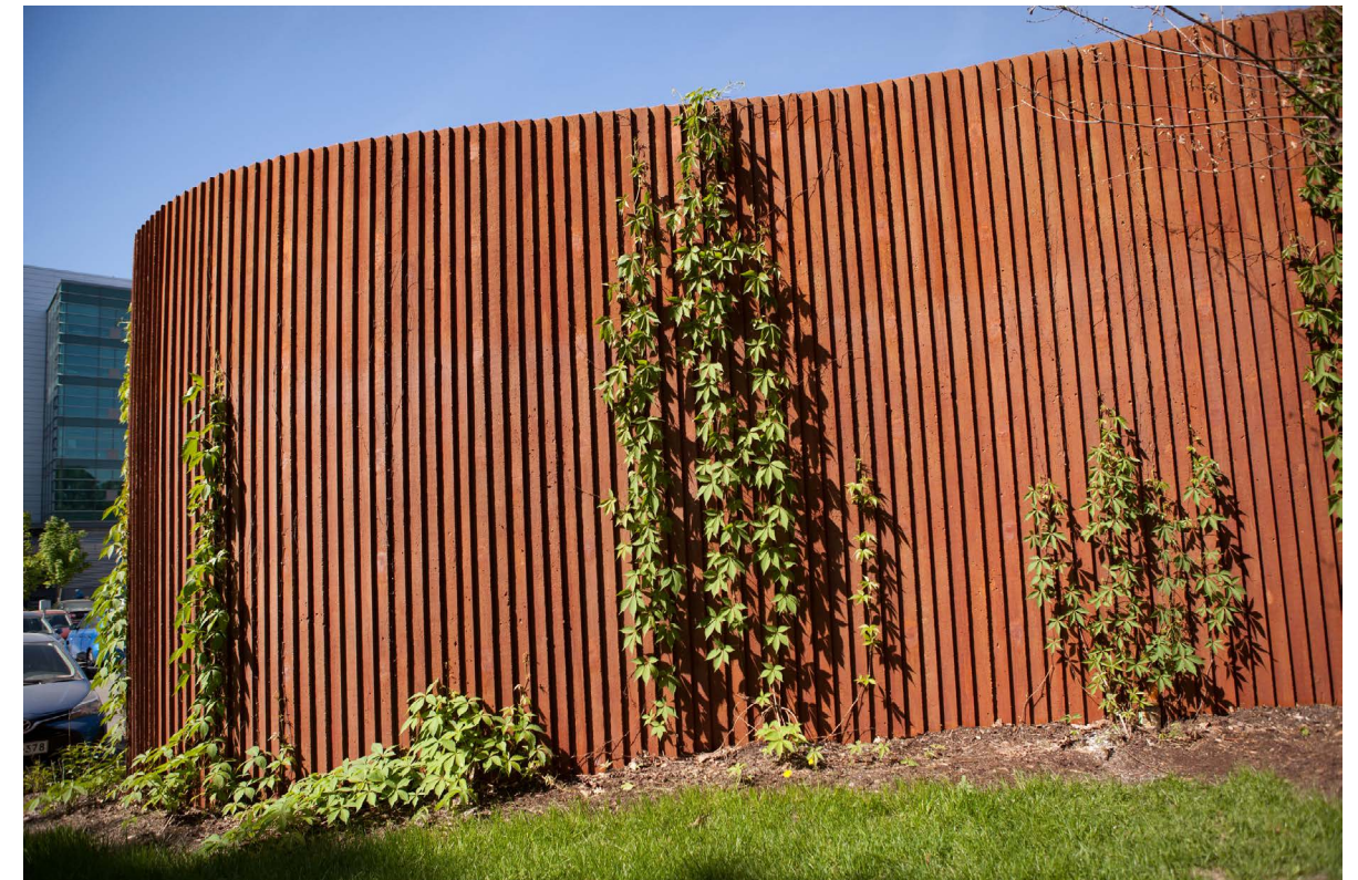
Esimerkki köynnösten käytöstä tukimuurissa, kuva Art-betoni Oy
