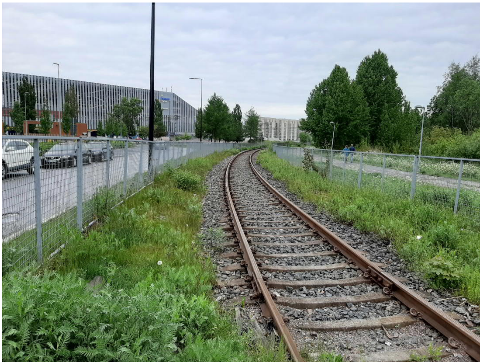
Kuva 2. Santarata raitiotien tulevalla risteyskohdalla
