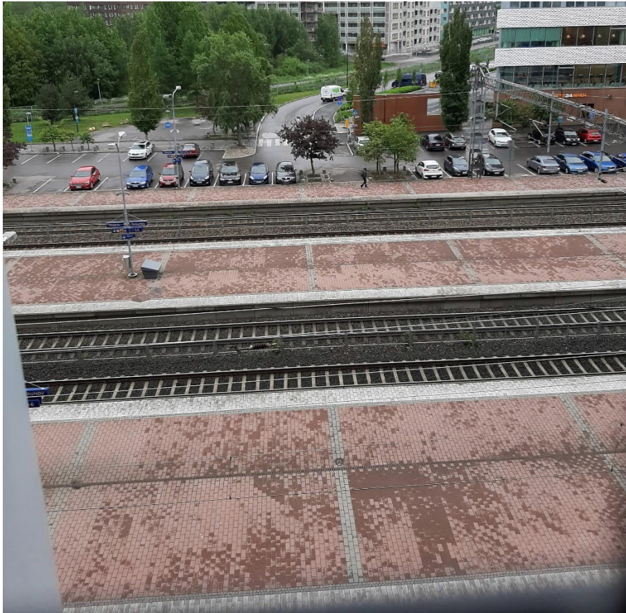
Kuva 6. Ratapihan-alue rakennettavan betonitunnelin kohdalla
